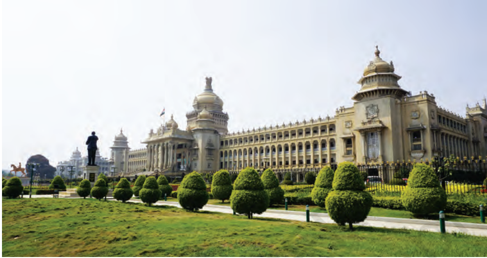
चित्र 6.12 — विधान सौध, कर्नाटक का विधानमंडल भवन। इस भवन की परिकल्पना केंगल हनुमंथैया ने की थी जो स्वतंत्रता सेनानी और संविधान सभा के सदस्य, कर्नाटक के मुख्यमंत्री और बाद में सांसद रहे।
